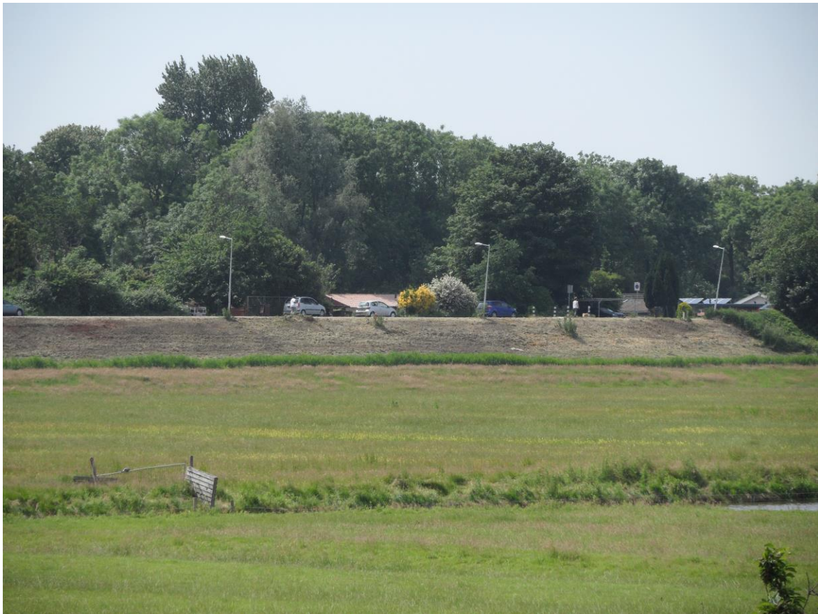
8 juni 2016. Gezicht vanuit de polder naar de dijk ná het klepelen; let op de kale plekken in het talud
